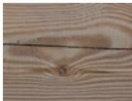
Spannungsriss durch die Holz-trocknung
