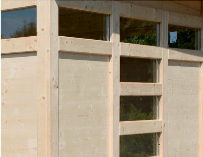
Lichtbänder isolierverglast (Doppelverglasung) und mit abgeschrägten Querriegeln für optimalen Wasserablauf.
