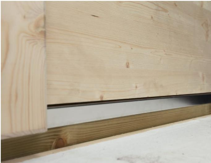
Konstruktiver Holzschutz: umlaufendes Abtropfblech (Z-Profil) aus Aluminium zwischen Boden und Wandmodulen.
