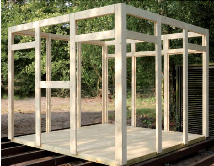
Stollen und Querriegel: aus kerngetrennter, kammergetrockneter, massiver nordischer Fichte in Sichtqualität. Außenstollen: 58 x 118 mm, Eckstollen 118 x 118 mm, wasserfest verleimt.
