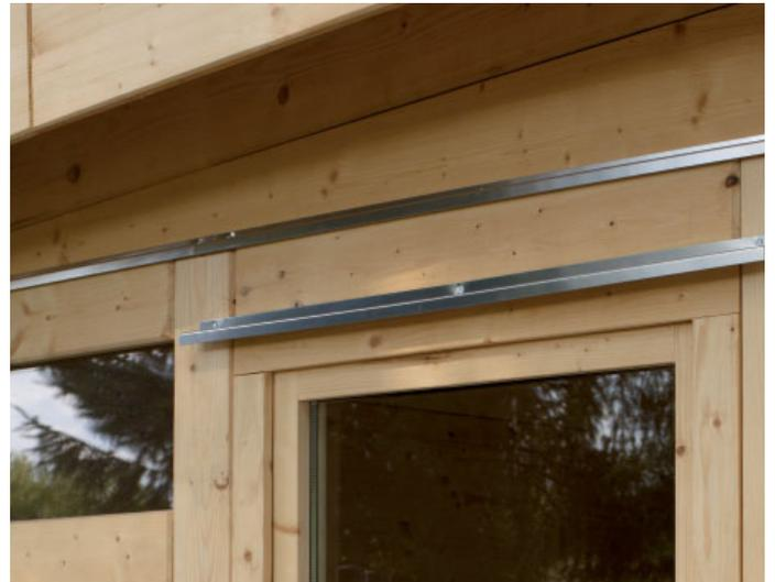
Abtropfblech über den Querriegeln, Fenstern und Türen aus Aluminium für konstruktiven Holzschutz.
