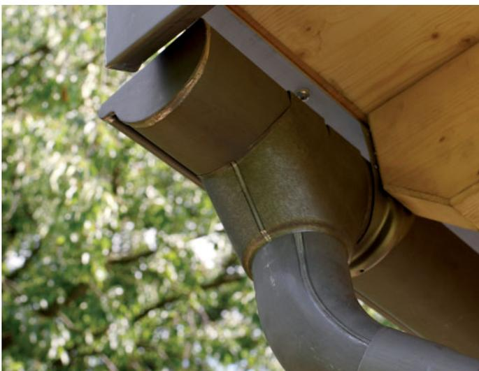
Zink-Rinne 8-tlg. mit eingelöteten Kopfstücken (links/rechts) inklusive Zink-Einhängstutzen, Zink-Fallrohr 8-tlg, Fallrohrmuffe, Rohrbogen, Rohr-
