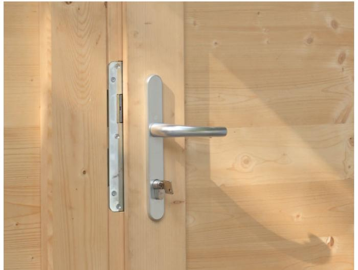
Hochwertige Türbeschläge: 3-teiliges Einbohrband mit wartungsfreier Gleitlagertechnik, Aluminium-Drückergarnitur-Schutzbeschlag, Profilzylinder, Drücker-Paar und Einsteckschloss (Abb. ähnlich)
