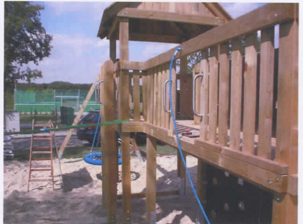
Bild 8: Turm, Angriffspunkt in Podesthöhe
