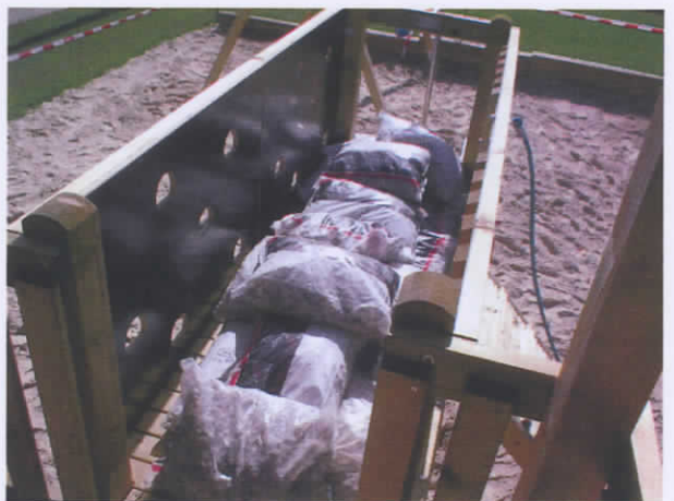
Bild 4: Belastung der Brücke
