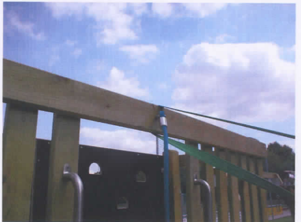
Bild 10: Zugversuch am Geländer
