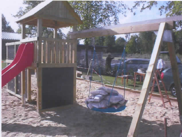
Bild 1: Prüfung des Schaukelgestells
