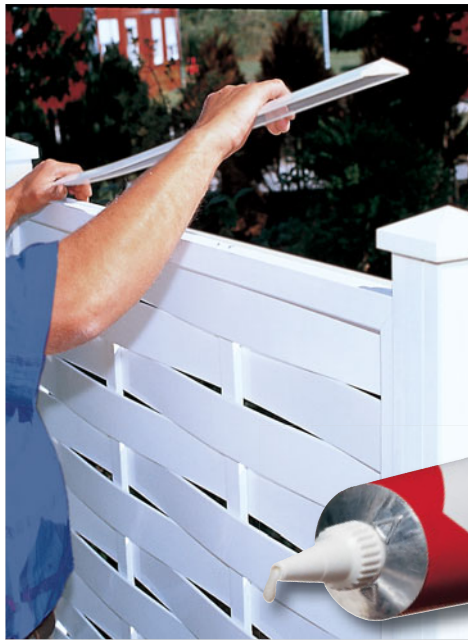
Colle (0783) pour la fixation des profilés de finition et des chapeaux en PVC.
