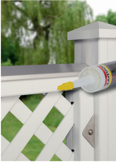
Designaufsatz Alu mit MS-Polymer-Kleber (1398) befestigen.
