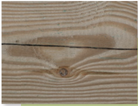
Spannungsrisse durch die Holz Trocknung
