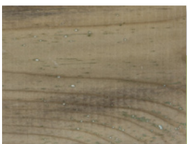
Stockflecken und leichter Schimmelbefall
