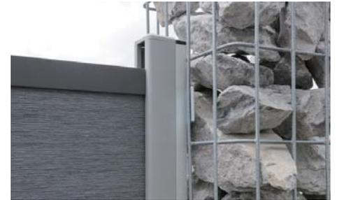
Pour le montage des panneaux de clôture sur des gabions. Convient aux gabions de taille de maille standard de 5 cm. Kit contient 1 profilé de montage avec chapeau (1) et connecteurs avec matériel de fixation (2). Convient à tous les systèmes de clôture TraumGarten.
