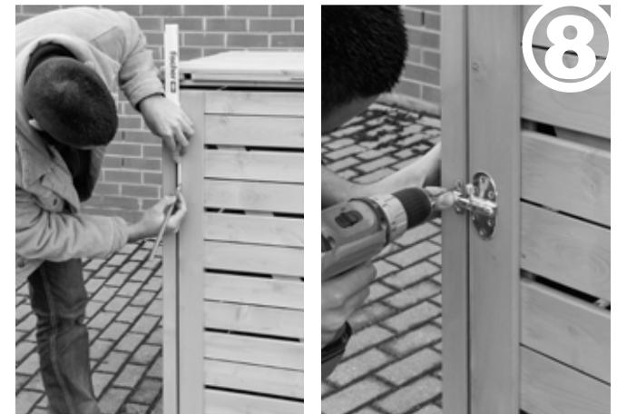
Den Riegel zum Schließen der NEO Müllbox in die gewünschte Höhe bringen und mit 3,0 x 16 mm Schrauben anbringen.
