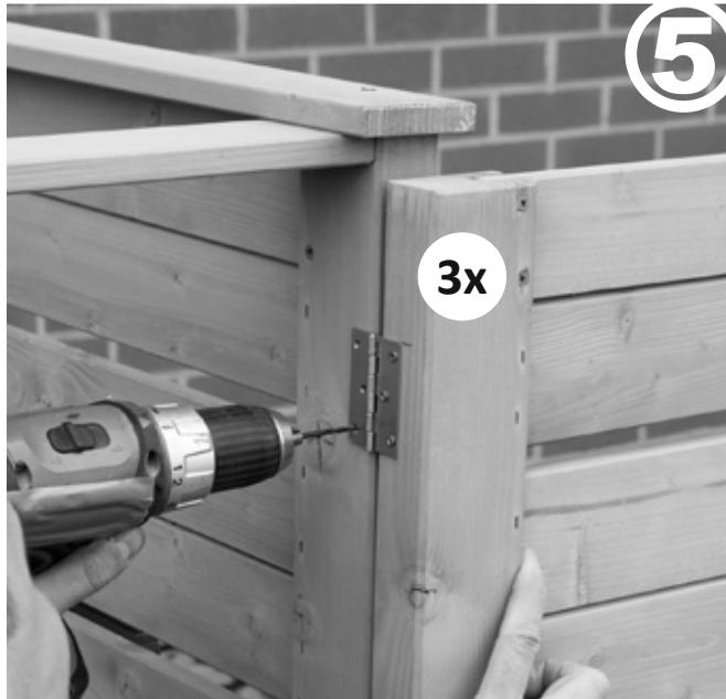
Die Position der Tür in der Höhe mittig ausrichten und die Türscharniere an der Innenseite des Rahmens befestigen (mit 3,0 x 30 mm Schrauben).
