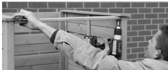
Die vordere Abdeckleiste (f) wird bündig zwischen die Seitenwände gesetzt. Bohren Sie von unten in die seitlichen Abdeckleisten vor und verschrauben Sie diese mit 4,0 x 25 mm Schrauben. Hinweis: Die seitlichen Abdeckleisten stehen etwas vor.
