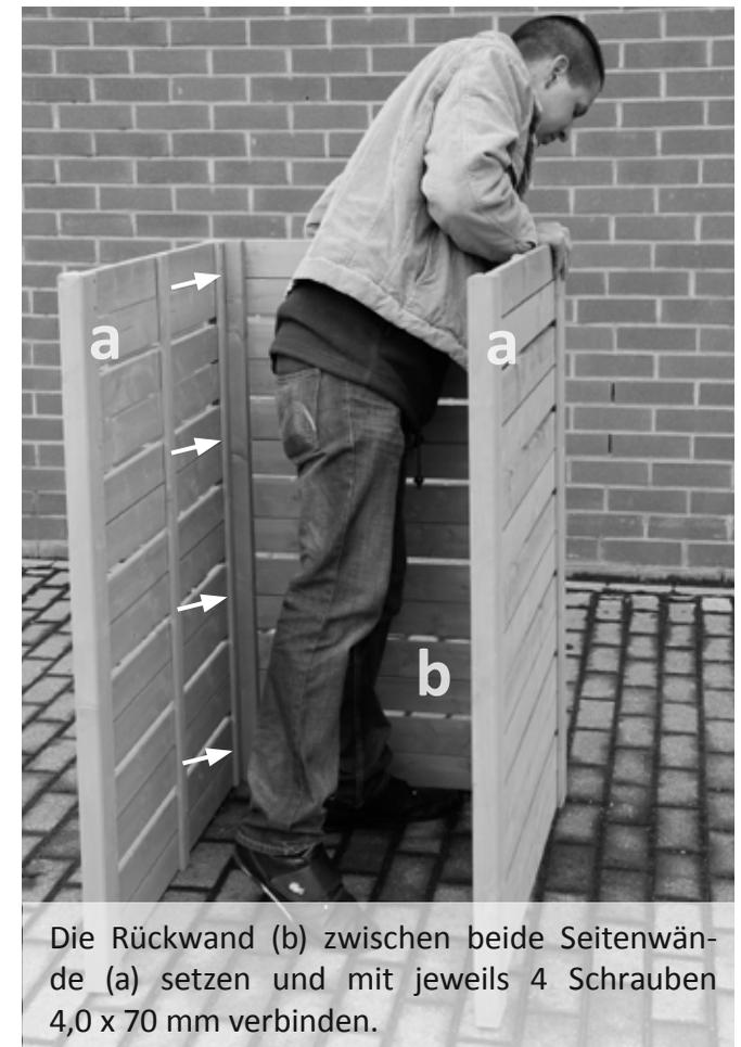
Die Rückwand (b) zwischen beide Seitenwände (a) setzen und mit jeweils 4 Schrauben 4,0 x 70 mm verbinden.
