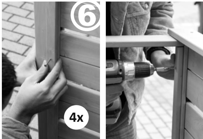
Die Anschlagleiste (g) mit der flachen Seite innen an den Rahmen der Seitenwand mit 4,0 x 40 mm Schrauben befestigen.
