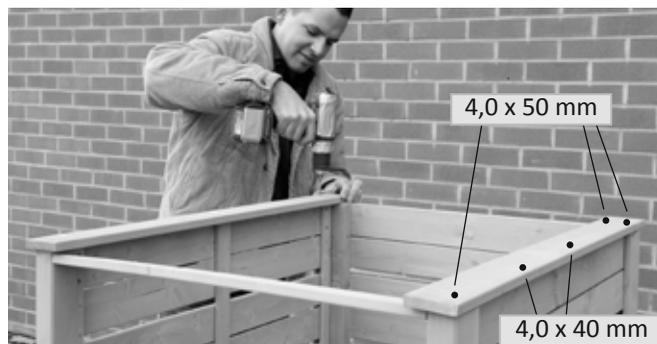
Die seitlichen Abdeckleisten (e) für den Klappdeckel sollen hinten und an der Außenseite bündig aufgesetzt werden. Die Abdeckleisten hinten mit 2 und vorne mit 1 Schraube von oben in die senkrecht stehende Rahmenleiste schrauben.
