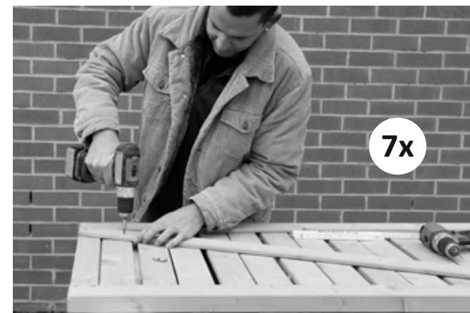
Zwei Scharniere ca. 8 cm von oben und unten an der Anschlagseite mit 3,0 x 16 mm Schrauben anbringen. Anschließend die Diagonalstrebe (h) auf der Innenseite der Tür befestigen (4,0 x 25 mm Schrauben). Die Türwand kann als DIN links und DIN rechts verwendet werden. Die Diagonalleiste muss innen so angebracht werden, dass sie diagonal von oben nach unten zur Scharnierseite verläuft.
