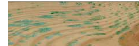
Salzablagerungen verblassen mit der Zeit
