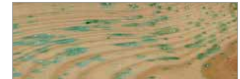
Salzablagerungen verblassen mit der Zeit
