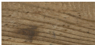
Stockflecken und leichter Schimmelbefall
