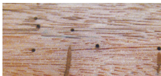
„Pinholes“ bei überseeischen Harthölzern
